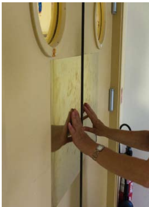
Bild 5: Centre Hospitalier de Rambouillet: Schwingtüre in Nahaufnahme mit antimikrobiellen Türplatten
